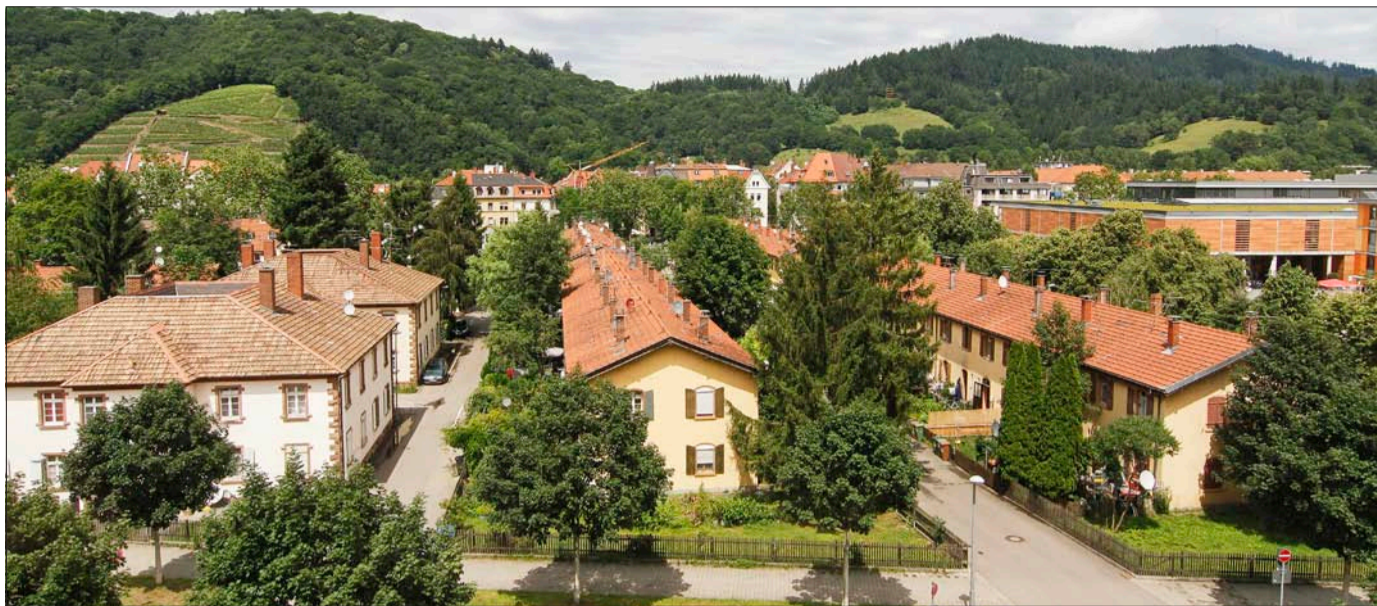
Denkmalgerecht sanieren will die Stadtplanung die Knopfhäuslesiedlung in der Oberwiehre.
